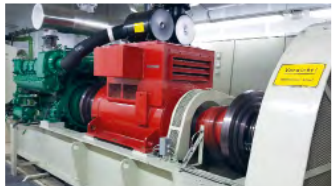
Aufbau Notstromaggregat
