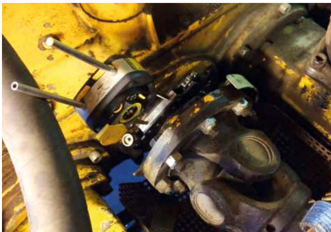
Prüfung der Ausrichtung der Flanschparallelität
